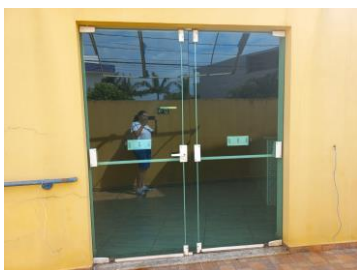
Porta entrada lateral salão
