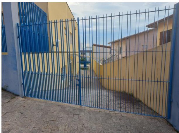
PORTÃO AUTOMATIZADO (ANTES)
